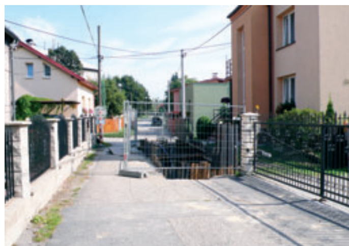
Obr. 6: Vstupní jáma reliningu na Luční ulici
