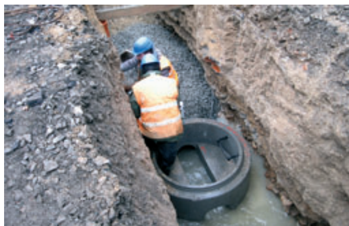
Práce na obnově vodohospodářských sítí v Chrastavě po povodních v srpnu 2010
