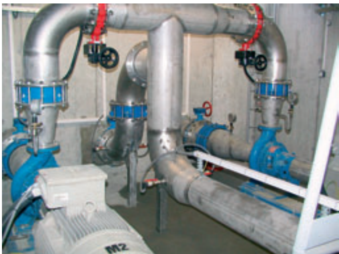
Obr. 4: Havarijní čerpací stanice „U univerzity“ v Karviné (umístění v podzemní šachtici)
