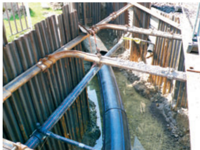
Obr. 7: Zatažené potrubí PE DN 600
