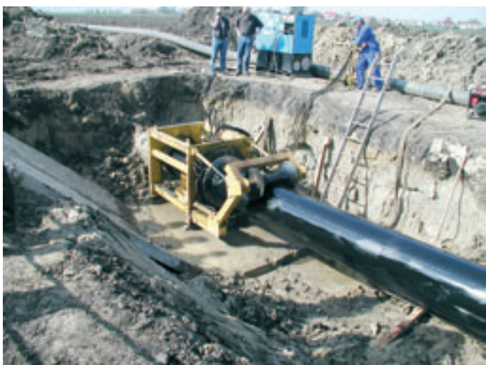
Obr. 5: Redukční kroužek technologie swagelining (ukázka z jiné stavby realizované zhotovitelem)
