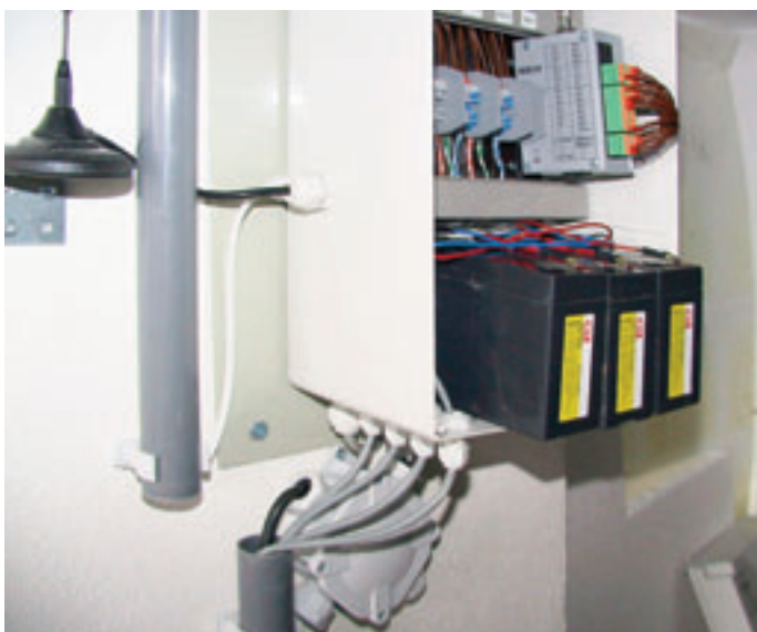
Obr. 1: Detail rozvaděče telemetrie
