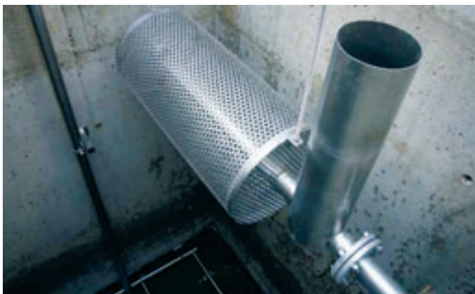
Obr. 2: Odtoková síta a speciální dělící stěna
