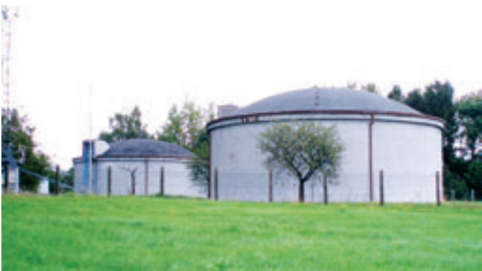
Obr. 1: Komory vodojemů Doubrava jsou typickým řešením akumulací na poddolovaném území (založeno na železobetonové desce tvaru čochy pro eliminaci případného naklonění objektu)
