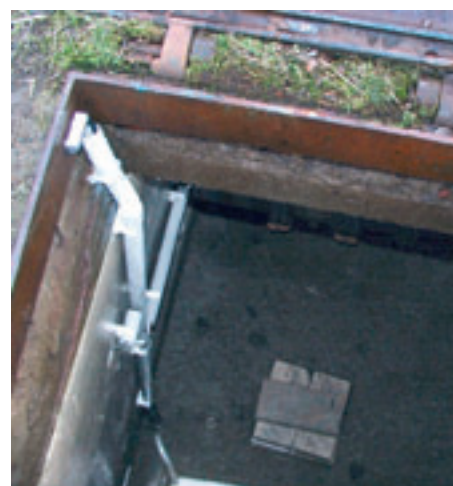
Obr. 5: Příklad signalizace vstupu do objektu RŠ Raduň
