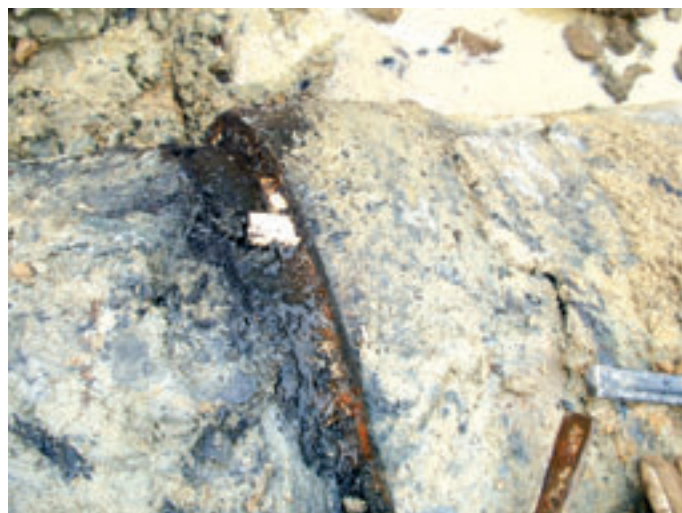
Obr. 2: Porucha hrdlového spoje typu Schalker
