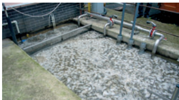
Obr. 3: Reaktor s MBBR technologií
