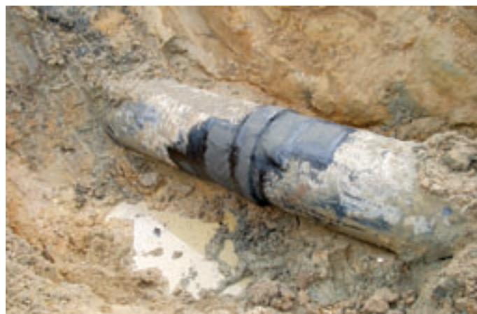
Obr. 3: Oprava hrdla převažením prstence
