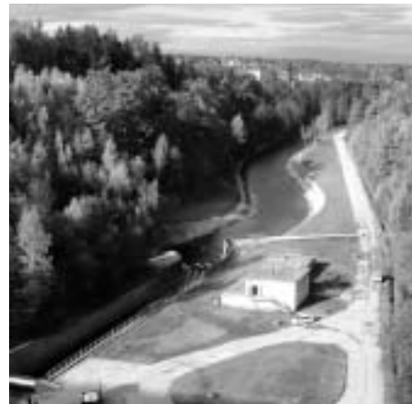
Předávací objekt JVS pod přehradou Římov
