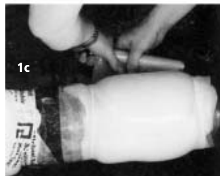
Obr. 1a–c: Dvousložkovou stěrkovou hmotu PolyForm™ je možno jednoduše nanášet na prasklé potrubí
