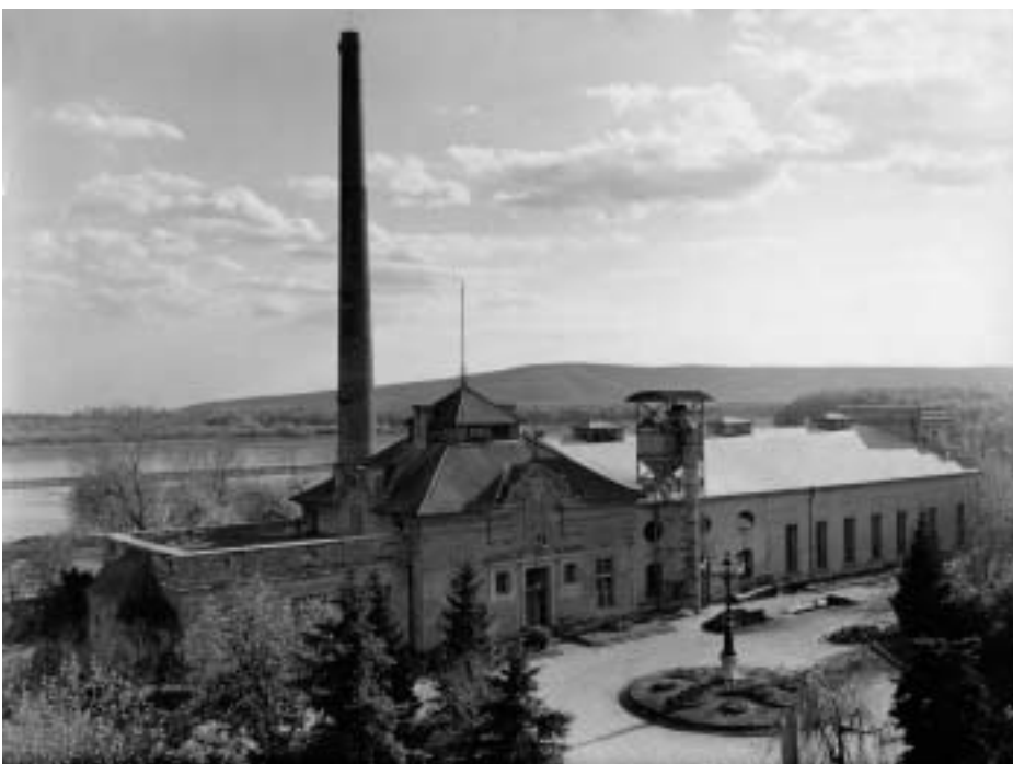
Čerpacia stanica v Karlovej Vsi – budova Vodárenského múzea (dobová fotografia)
