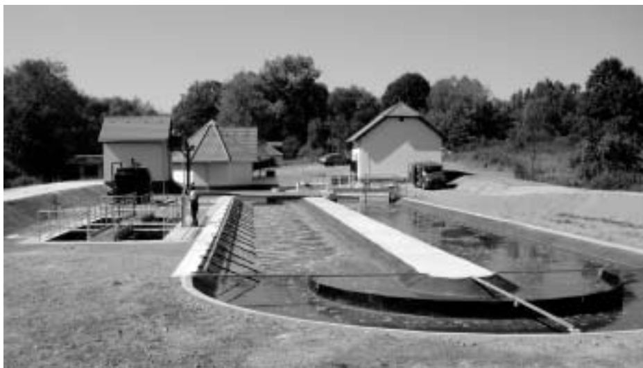
ČOV Dolní Dvořiště
