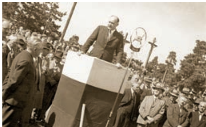
Slavnostní zahájení stavby vodovodu, rok 1936
