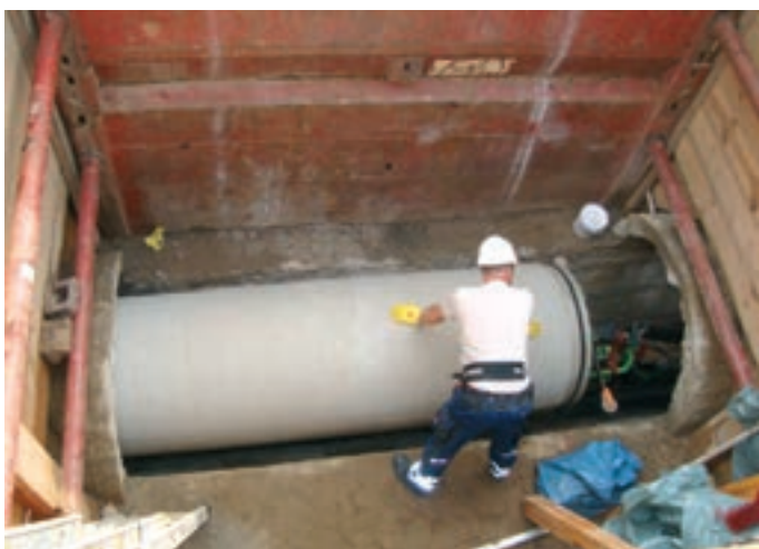
Instalace speciálních profilů kyvadlovým vozíkem na trubky. Foto: Aarsleff Rohrsanierung GmbH
