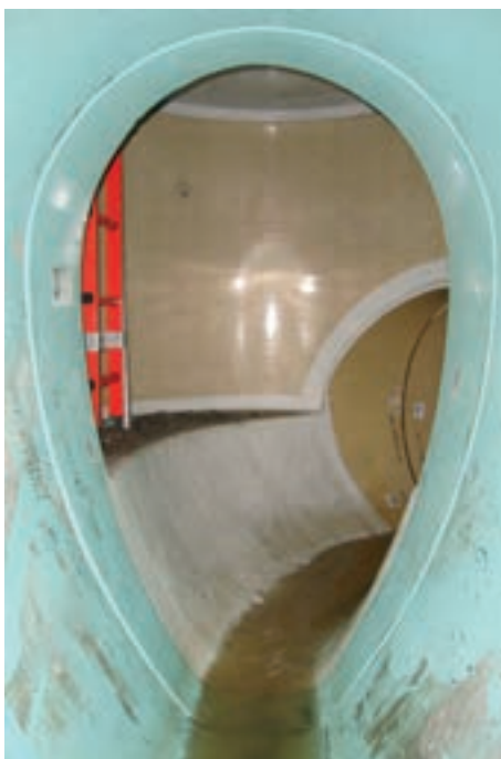
Kromě vejčitých profilů z GPR byly instalovány tři tangenciální šachty DN 1 000 a jedna hrncová šachta DN 1 600 a obložena šachta ke snížení tlaku (DUS) materiálem GPR. Foto: Aarsleff Rohrsanierung GmbH
