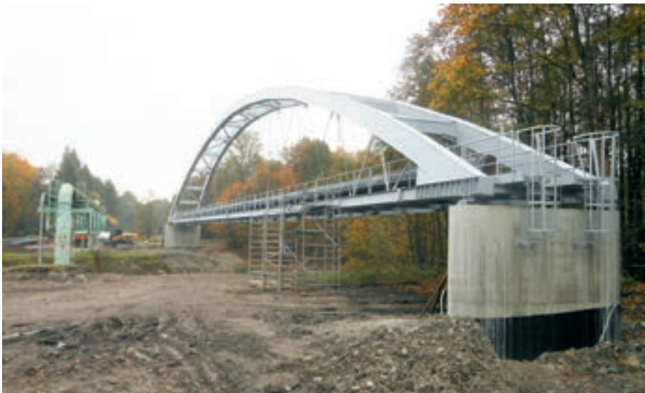
Obr. 8: Výstavba nového přemostění – pohled z levého břehu řeky Morávky. Původní trubní most je vidět vlevo od nového mostu
