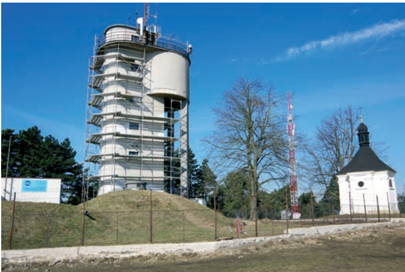
Vodojem při opravě s lešením, rok 2015
