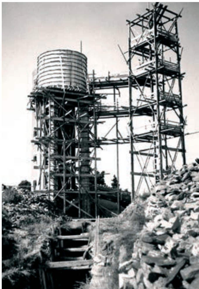
Vodojem ve výstavbě s lešením, rok 1937
