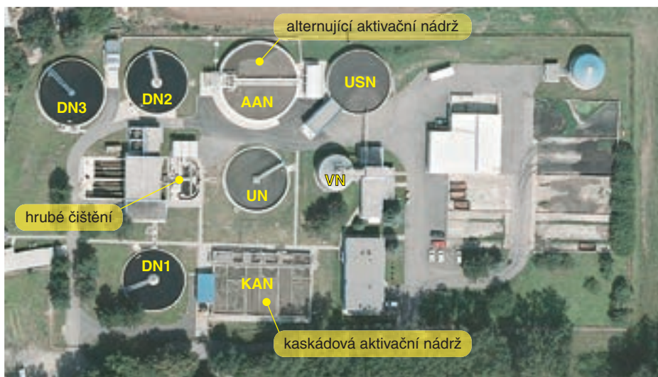
Obr. 1: Letecký snímek ČOV Nový Jičín s vyznačením hlavních objektů
