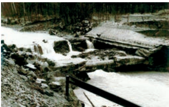
Obr. 1: Poškození shybky po povodni krátce před výstavbou původního přemostění ve druhé polovině 80. let 20. století
