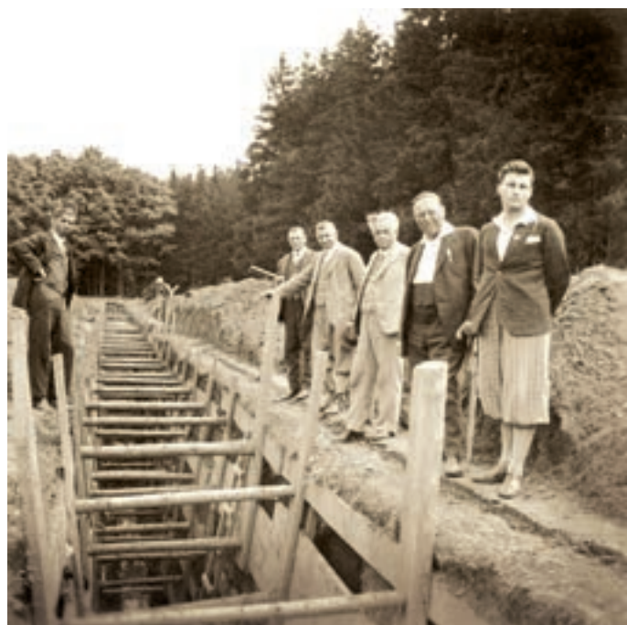
Stavba Heraltického vodovodu, rok 1937
