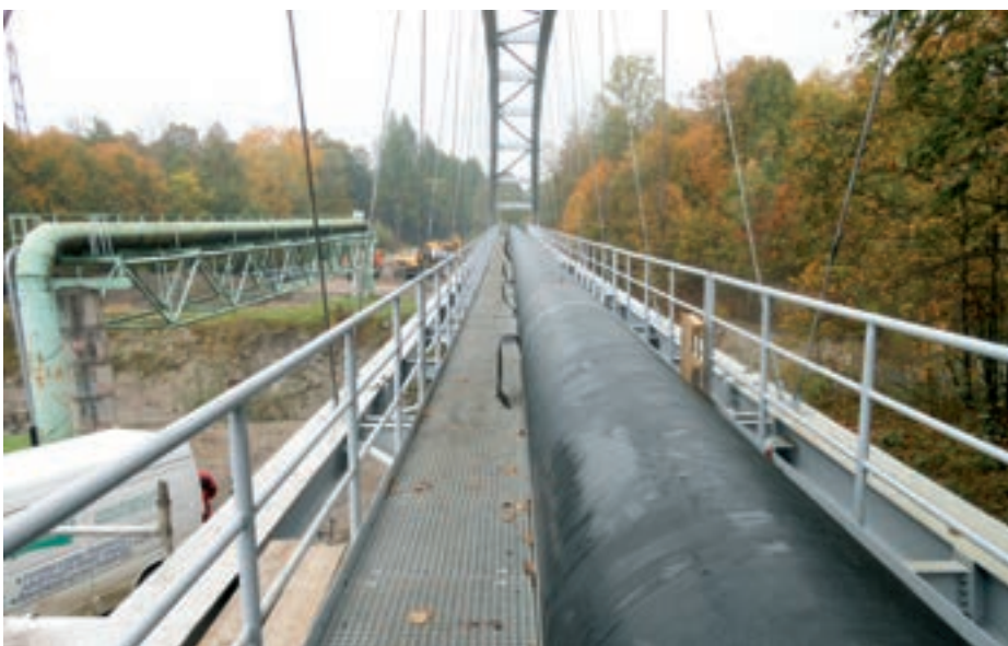
Obr. 9: Pokládka potrubí na nové přemostění řeky Morávky. Vlevo je vidět původní přemostění řeky Morávky
