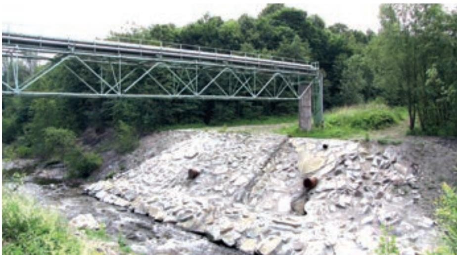
Obr. 5: Detail stabilizace levobřežní opěry původního přemostění (pohled proti toku řeky). V opevnění je jasně vidět zaslepené potrubí původní dvouramenné shybky DN 800 (stav v roce 2011)
