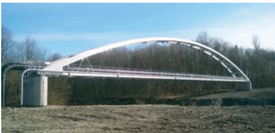
Obr. 10: Nově navržený trubní most přes řeku Morávku
