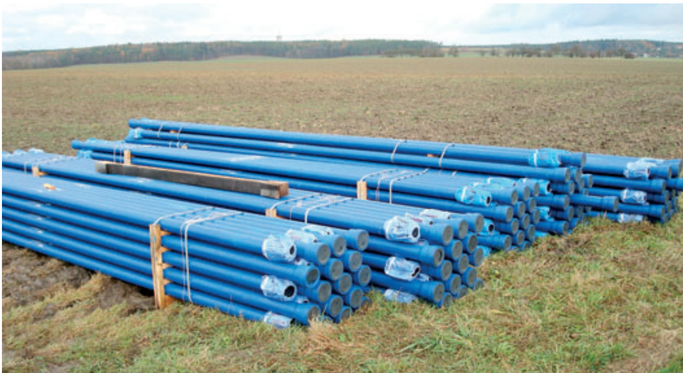
Obr. 1: Dodávka trubek BLUTOP ve svazcích (1 svazek DE 90 = 180 metrů, 1 svazek DE 110 = 120 metrů)
