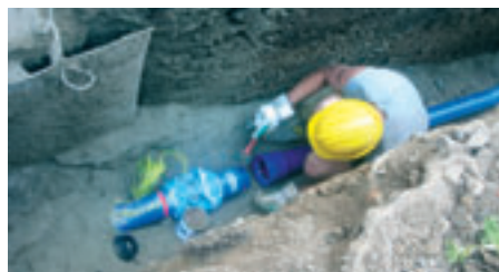
Obr. 3 až 5: Ukázka uložení potrubí ve výkopu, aplikace úhlového vychýlení
