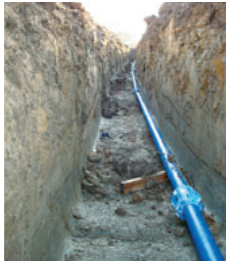
Obr. 3 až 5: Ukázka uložení potrubí ve výkopu, aplikace úhlového vychýlení
