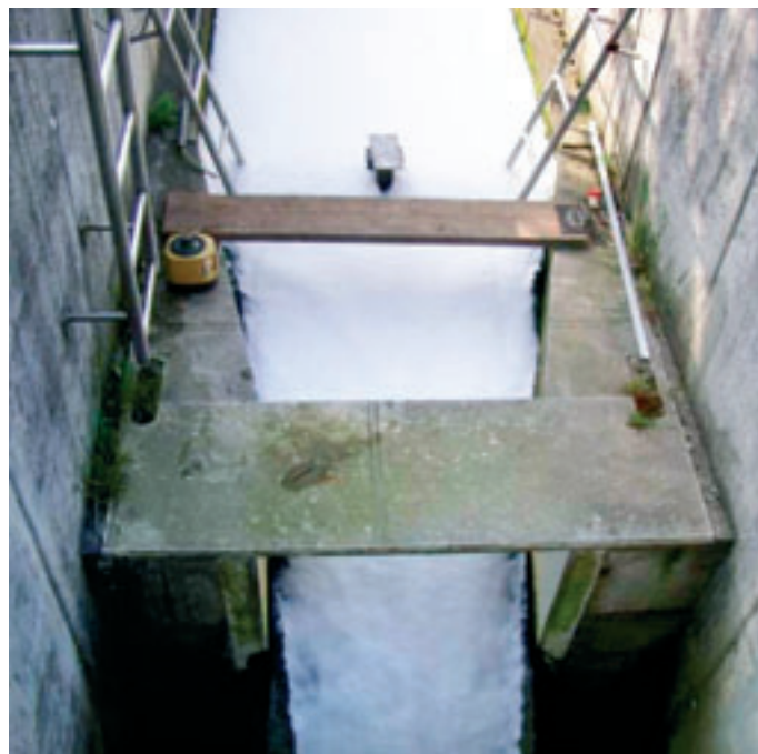
Obr. 4: Výskyt pěny v profilu pod ultrazvukovým snímačem
