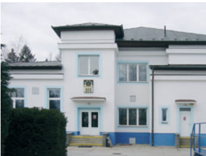
Úpravna vody Tábor-Rytíř
