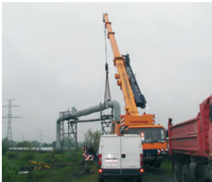
V Karviné rozvodněný tok potoka Loucká Mlýnka podemlel základy břehového pilíře, porušil statiku mostu a poškodil potrubí hlavního přivaděče pitné vody pro Karvinou. Provizorně byl trubní most zajištěn jeřábem.
