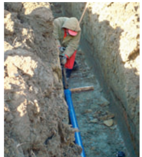
Obr. 9: Ruční montáž potrubí
