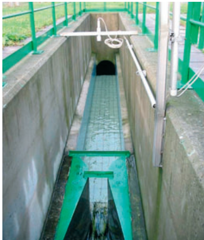
Obr. 2: Protiproudň pohled na přítokové koryto před měřicím systémem
