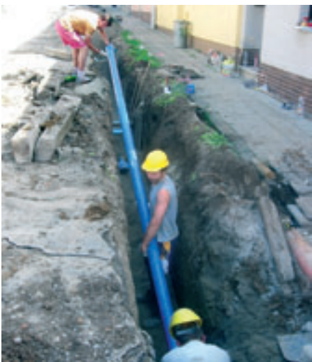
Obr. 6: Ruční manipulace s trubkami
