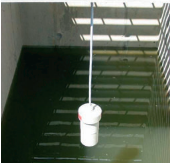
Obr. 3: Nesprávné upevnění snímače pouze na napájecím kabelu bez použití nosné konstrukce
