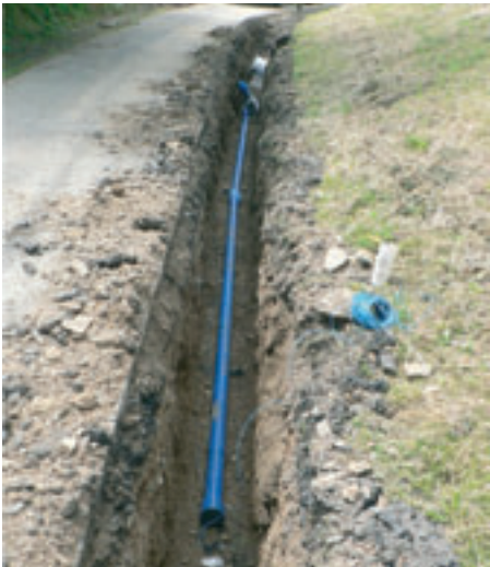
Obr. 3 až 5: Ukázka uložení potrubí ve výkopu, aplikace úhlového vychýlení
