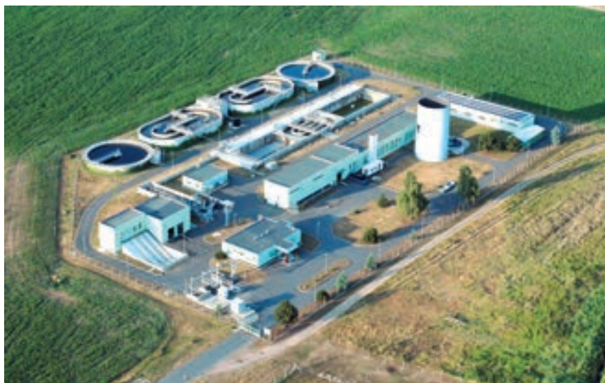
ČOV Bzenec po rekonstrukci
