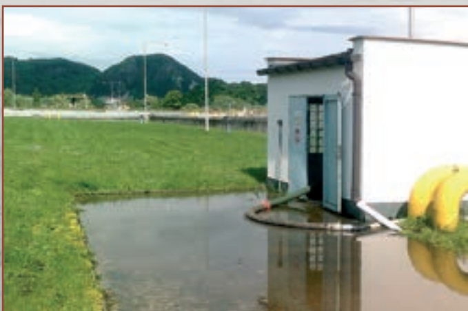
ČOV Ústí nad Labem-Neštětice
