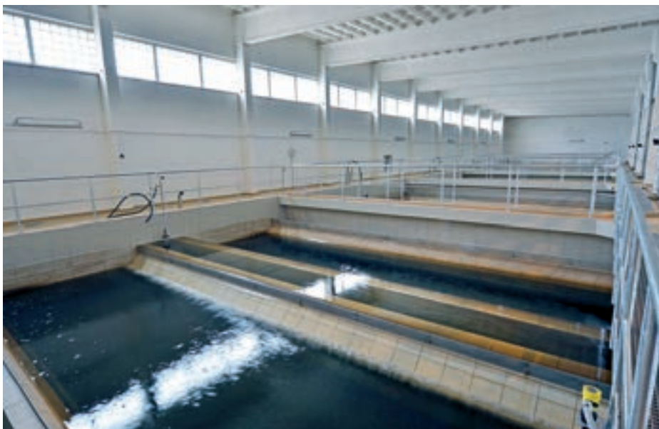
Filtrace na ÚV Sojovice po rekonstrukci
