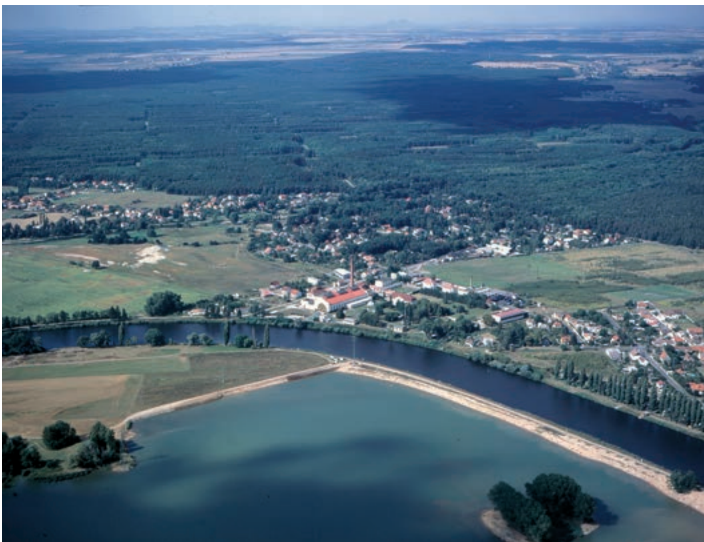
Letecký pohled na vodárnu Káraný
