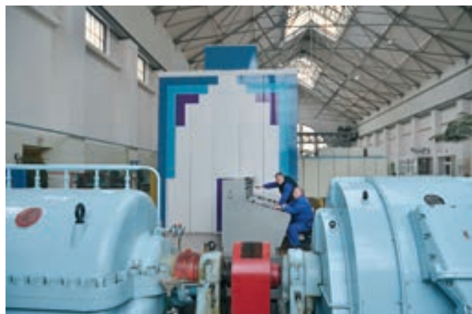
Káraný strojovna – obsluha hlavního čerpadla
