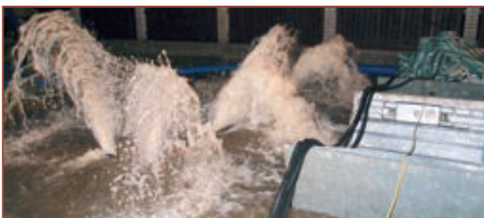
Zbraslav HK MČS U loděnice před vystřelením tlakového poklopu montážního otvoru
