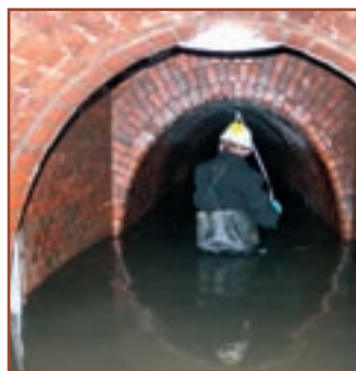
Výpust z kmenové stoky A před nátokovou komorou shybky Čechův most – kontrola funkce zpětné klapky
