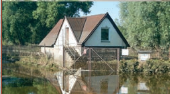
ČOV Kozárovice před a po opadnutí vody
