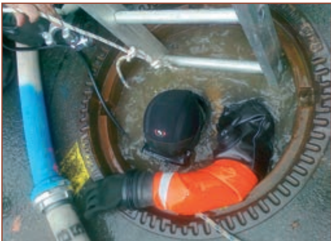
Kontrola šachty v Horních Počaplech
