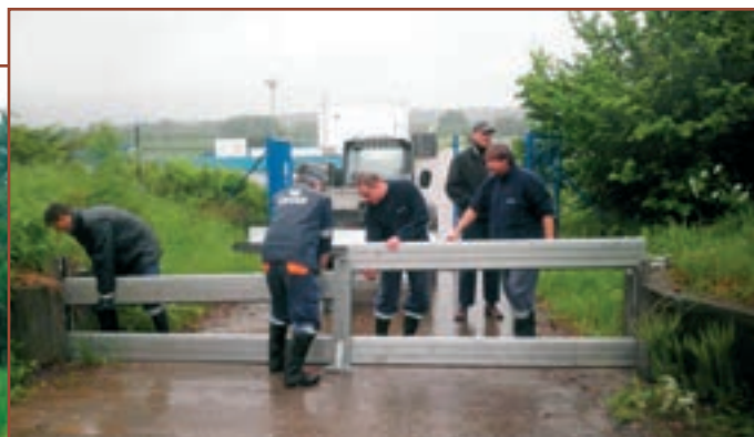
Stavba protipovodňové zábrany na ČOV České Budějovice
