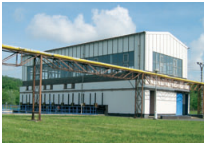
Obr. 7: Čerpací stanice mechanicky předčištěných vod
