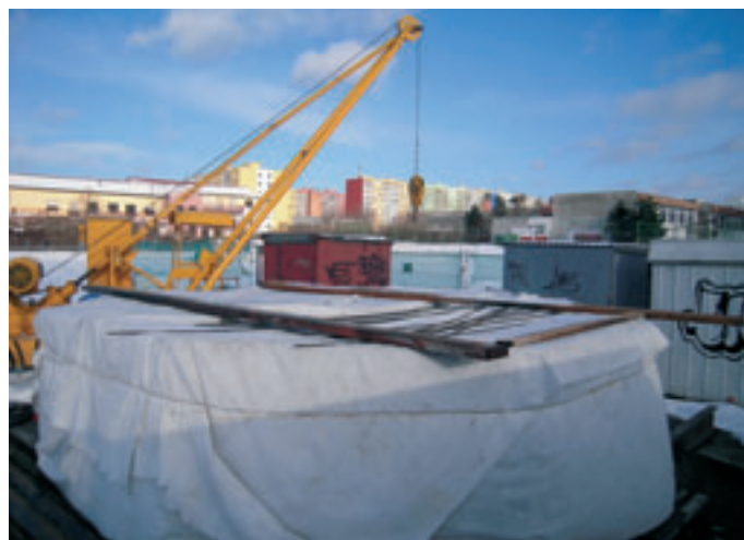
Obr. 8: Opatření pro betonáž v zimním období
