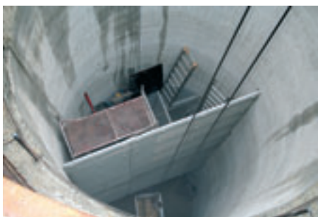
Obr. 9: Montáž lezního oddělení
