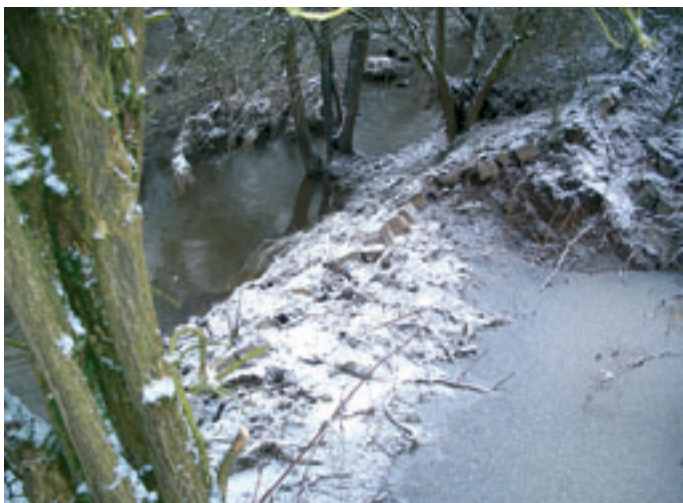
Obr. 2: Stavební jáma po ústupu povodně
