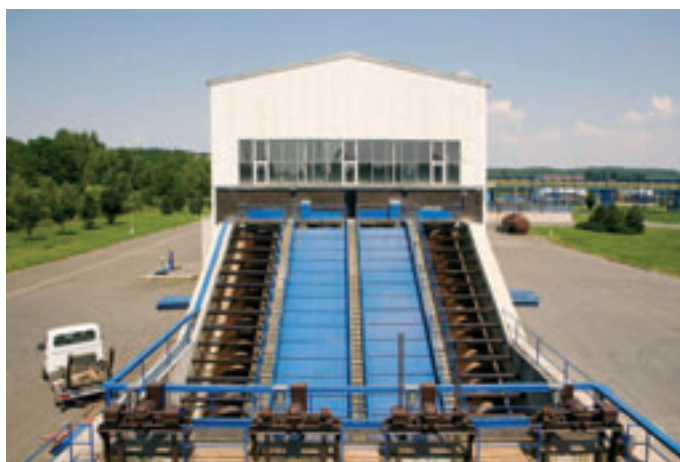
Obr. 6: Vstupní čerpací stanice na přivaděči „D“
