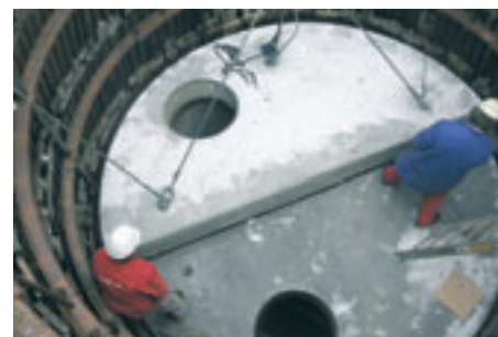
Obr. 11: Osazení stropní desky
