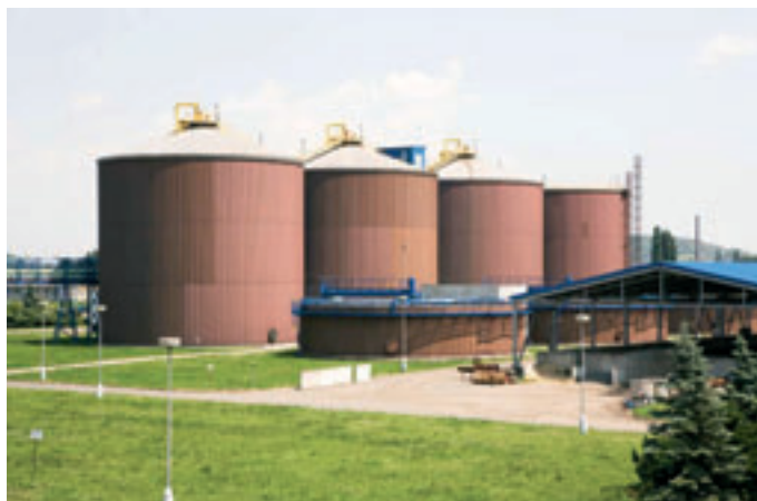
Obr. 5: Tři vyhřívací nádrže a uskladňovací nádrž
