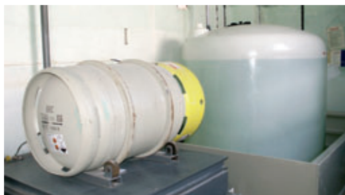
Obr. 5: Zásobní nádrž produktu vedle stávající technologie chlorování
