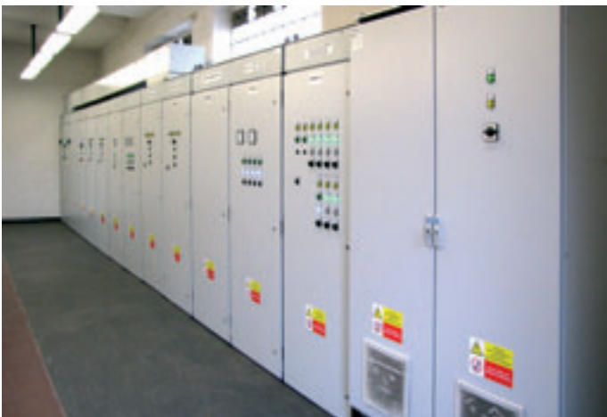
Obr. 2: Rozvodna v objektu dmýchárny
