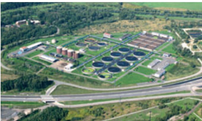
Obr. 1: Letecký snímek ÚČOV Ostrava
