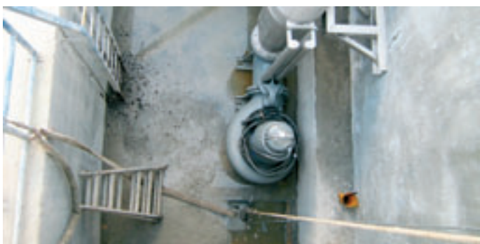
Obr. 10: Osazení ponorného čerpadla v nátokové galerii šnekového čerpadla
