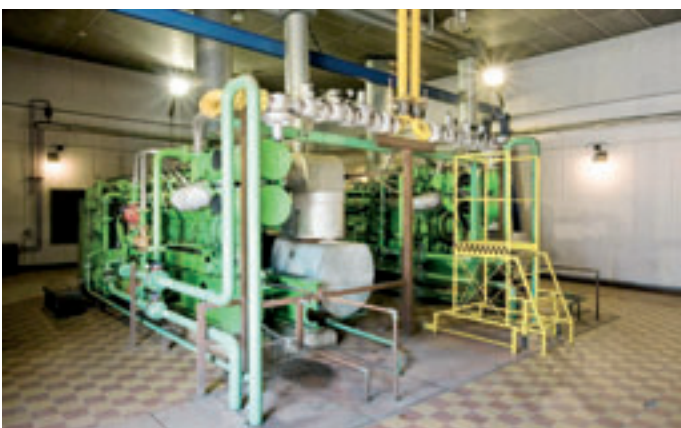
Obr. 3: Původní kogenerační jednotky Jenbacher
