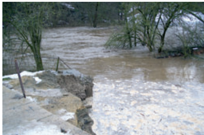
Obr 1: Zatopená stavební jáma
