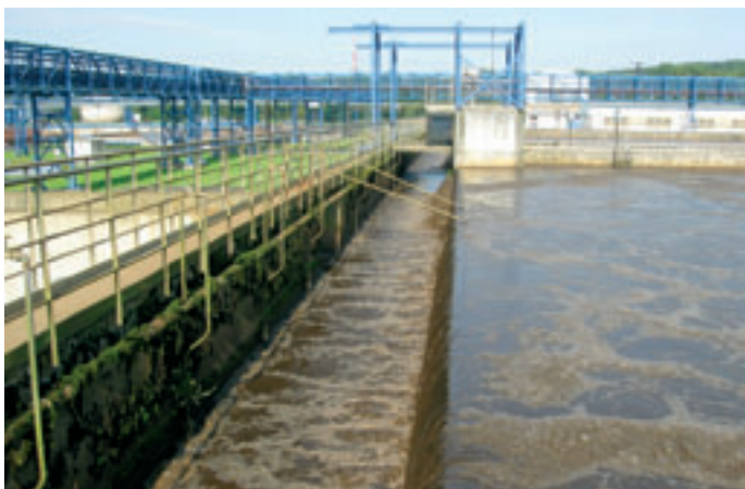
Obr. 4: Odtokový žlab na konci aktivačních nádrží
