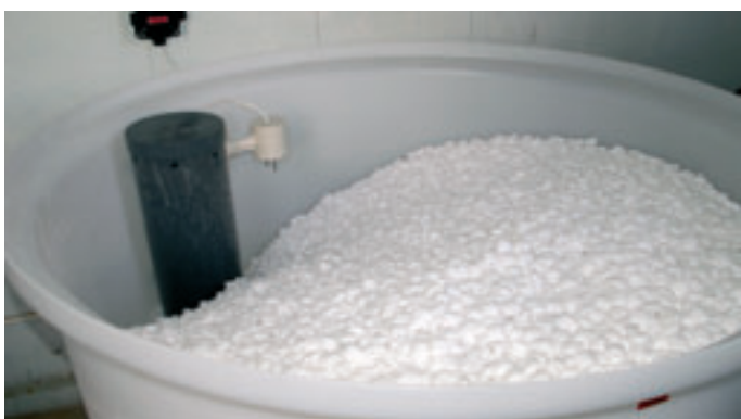
Obr. 3: Rozpouštěcí nádrž solanky
