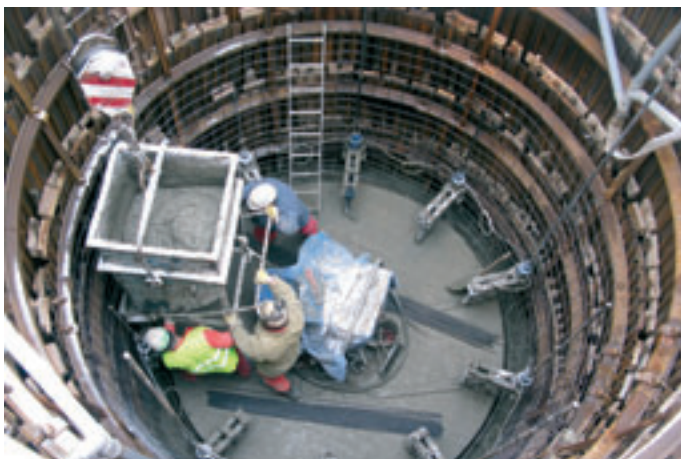
Obr. 7: Ukládání betonové směsi
