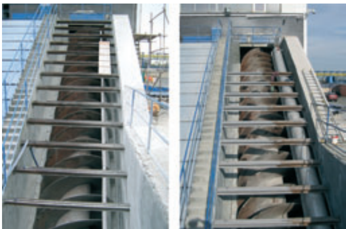
Obr. 8: Rotor šnekového čerpadla před úpravou
