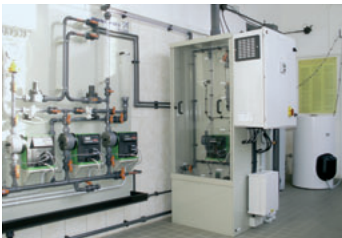
Obr. 4: Technologie dávkování chlornanu sodného s jeho výrobou v místě spotřeby
