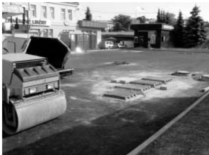
Dokončovací práce na zdrži ve Valašském Meziříčí
