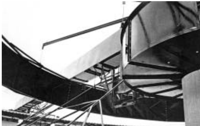
ČOV České Budějovice – vystrojení dosazovací nádrže
