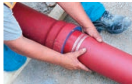
Obr. 3: Ruční montáž systému TOPAZ®
