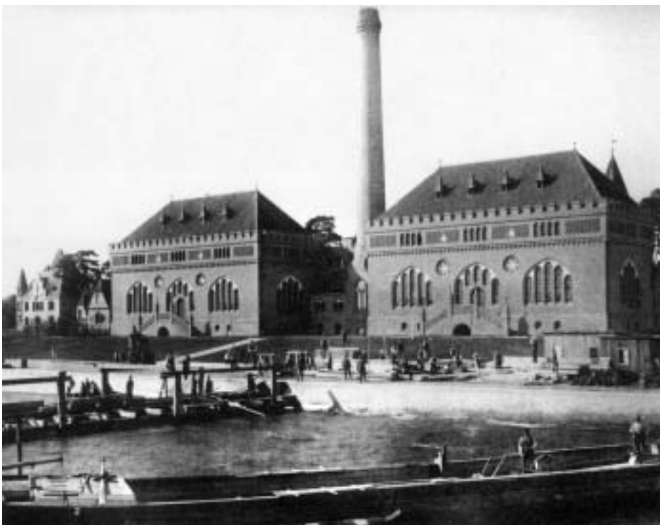
Vodárna Müggelsee (Friedrichshagen), exteriér čerpacích stanic
