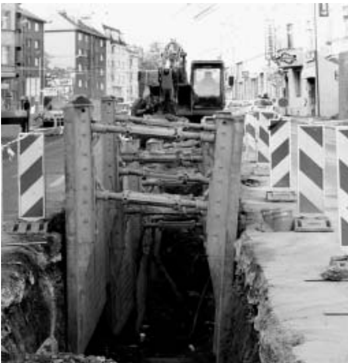
Projekt Podkrušnohoří – Dostavba Kanalizace Rekonstrukce kanalizace probíhala v centru města Ústí nad Labem za provozu (snímek z října 2005)
