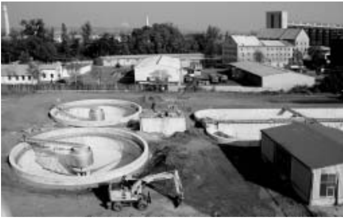
Projekt Podkrušnohoří – Rekonstrukce ČOV Záběr z průběhu rekonstrukce ČOV Žatec, říjen 2005
