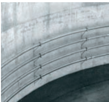
Obr. 9: Ocelový trubní had
