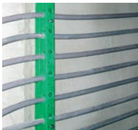
Obr. 10: Vytápění plastovými hadicemi
