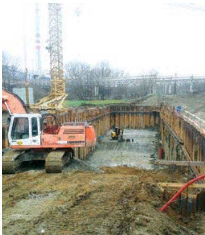
Obr. 5: Hloubení stavební jámy pro RN-OK1Na
