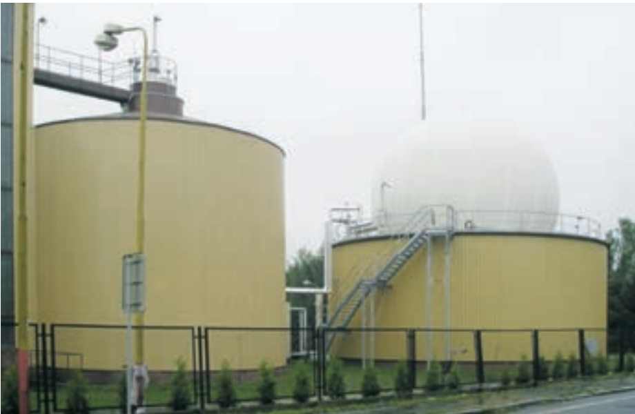
Obr. 6: Vlevo klasická, vpravo moderní vyhnívací nádrž
