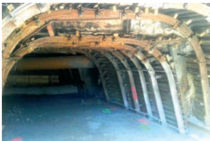
Obr. 10: Vyražená štola pod teplovodním kanálem – v pozadí obtokové potrubí a nátok do teplárny
