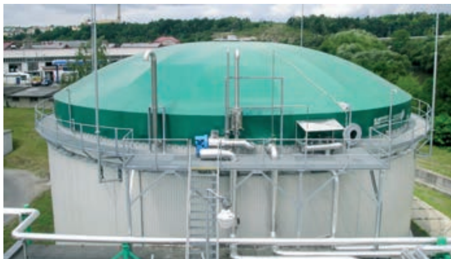
Obr. 12: Membránový plynojem nasazený na VN
