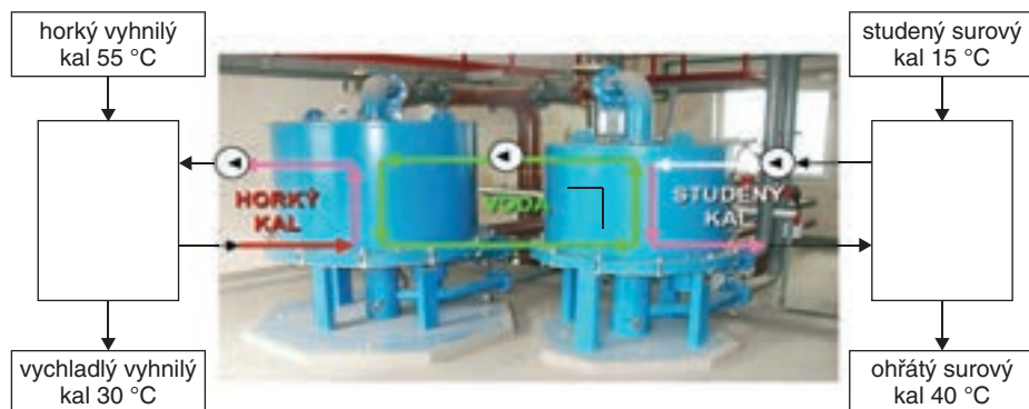
Obr. 13: Rekuperace tepla z vyhnílého kalu
