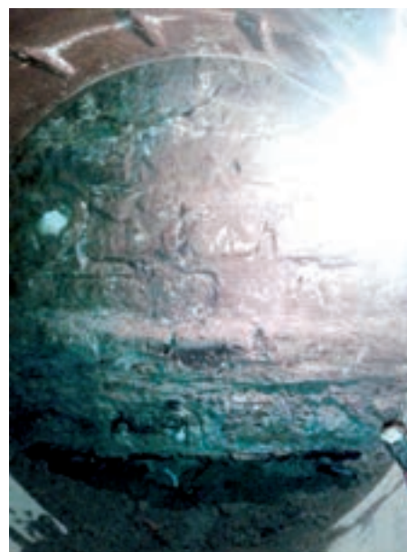
Obr. 3: Původní kamenná zeď v trase protlaku – DN 1 400
