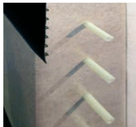
Obr. 11: Plastové trubky uvnitř betonové stěny nádrže
