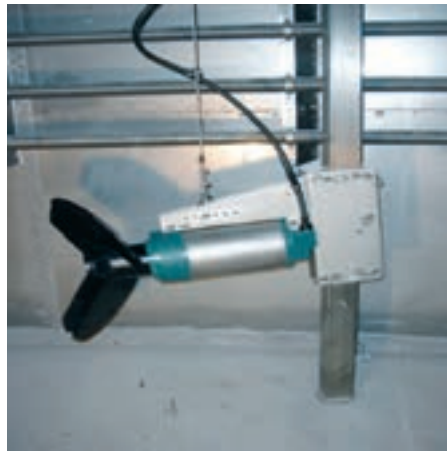
Obr. 8: Ponorné míchadlo
