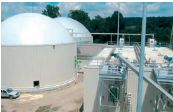
Obr. 6: Instalace anaerobních reaktorů COCCUS na komunální ČOV Akron (USA), převzato z materiálů firmy Bioferm Energy Systems
