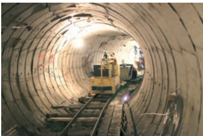
Obr. 9: Vyražená štola vystrojená železobetonovou obezdívkou
