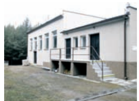
Obr. 6: Budova úpravy vody po dokončení celé rekonstrukce
