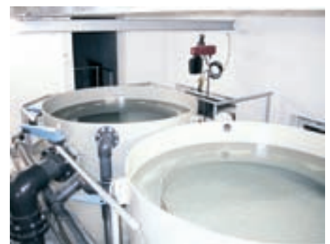
Obr. 5: Nové otevřené mramorové filtry protékané zdola nahoru
