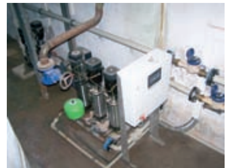
Obr. 4: Nová čerpací stanice a podávací čerpadla
