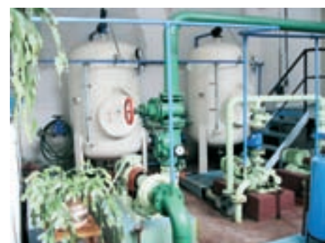
Obr. 3: Původní místnost čerpací stanice
