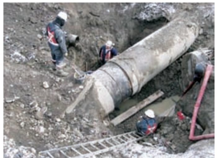
Obr. 7: Calgary – výkop Elbow Drive
