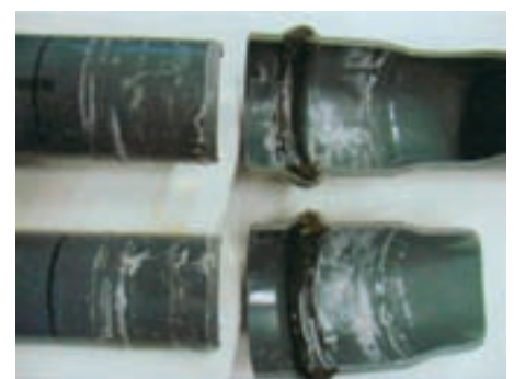
Obr. 4: Hrdlový spoj trub z PVC s nadměrným použitím kluzného prostředku na straně, která je ve styku s pitnou vodou, po 24 hodinách statického máčení a 1 hodině proplachu
