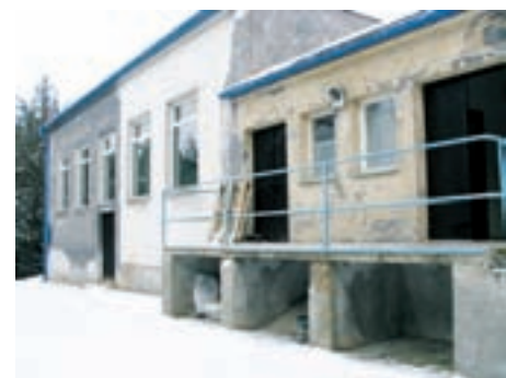
Obr. 1: Budova úpravy vody před rekonstrukcí
