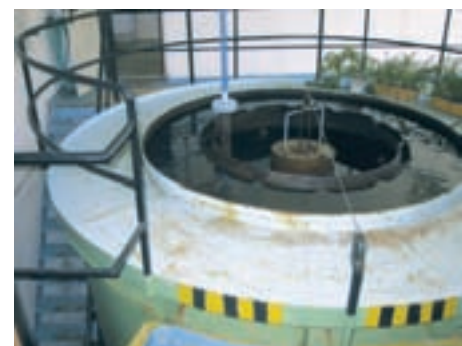
Obr. 2: Původní filtrační zařízení
