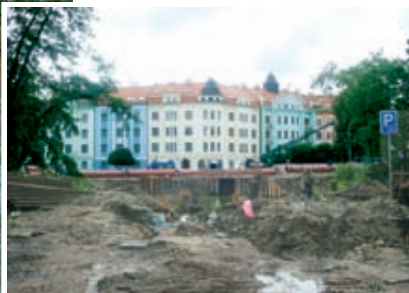
Obr. 4: Štětová stěna na břehu
