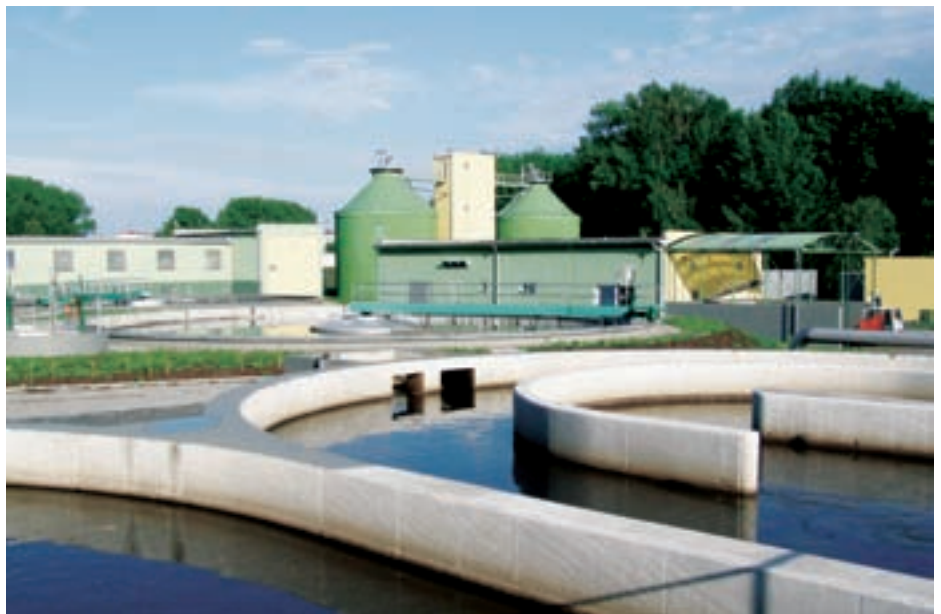
ČOV Uherské Hradiště
