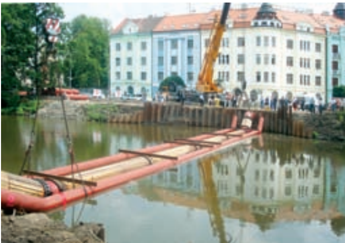
Obr. 7: Pozice shybky před napuštěním vodou
