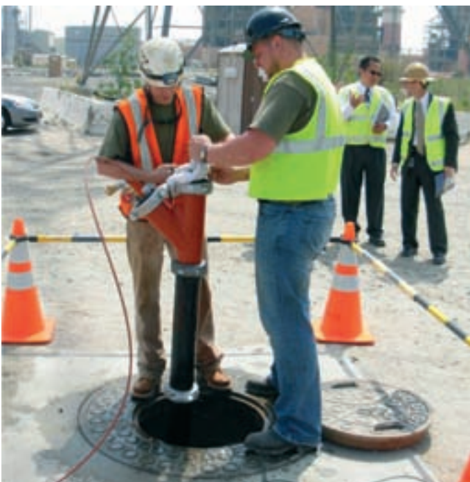
Obr. 5: Typické uspořádání pro vytažení balónku z potrubí
