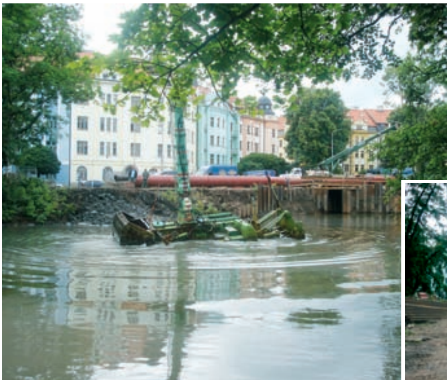
Obr. 3: Příprava rýhy podvodním bagrem Komatsu
