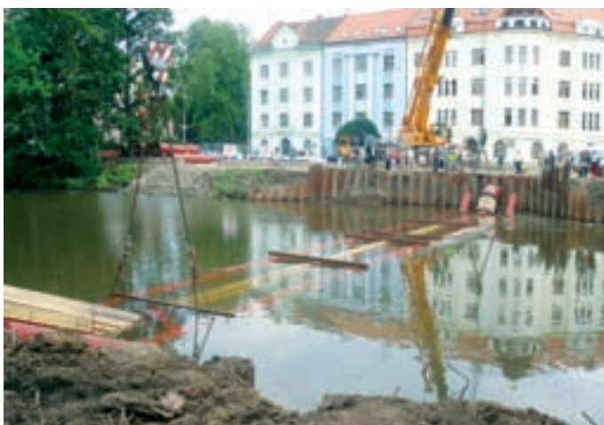
Obr. 8: Zaplavení shybky
