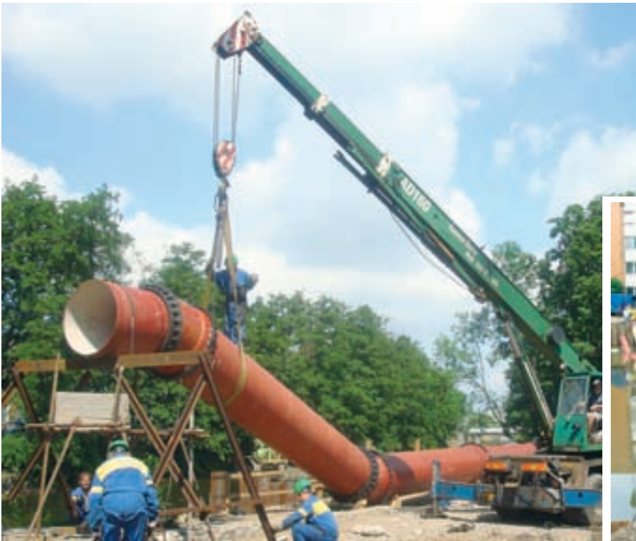
Obr. 5: Montáž shybky na povrchu
