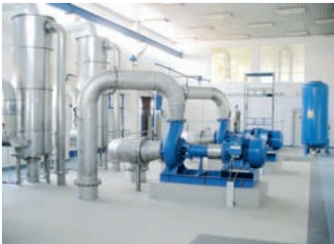
ÚV Ostrožská Nová Ves – čerpací stanice
