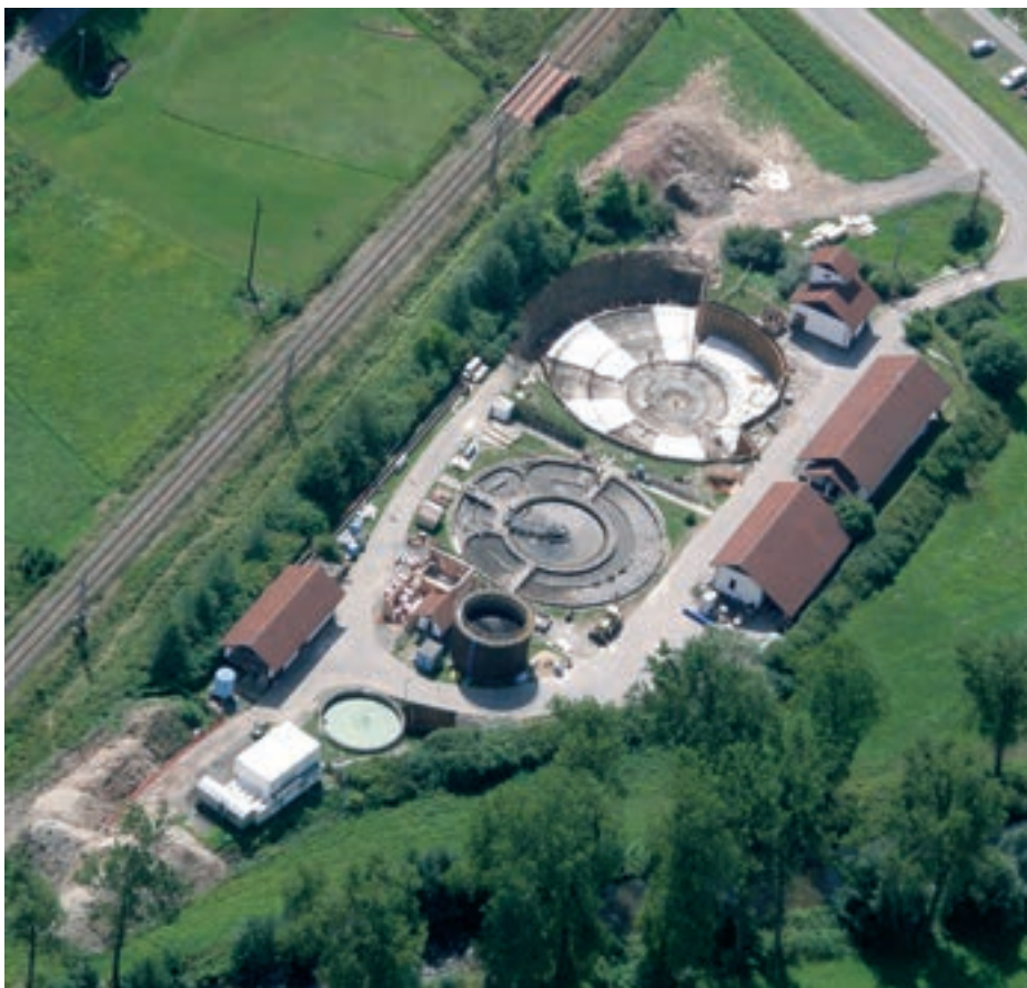
ČOV Letohrad v průběhu stavby nové biologické linky (letecký pohled podzim 2013)
