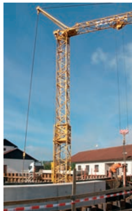
Z výstavby nové biologické linky
