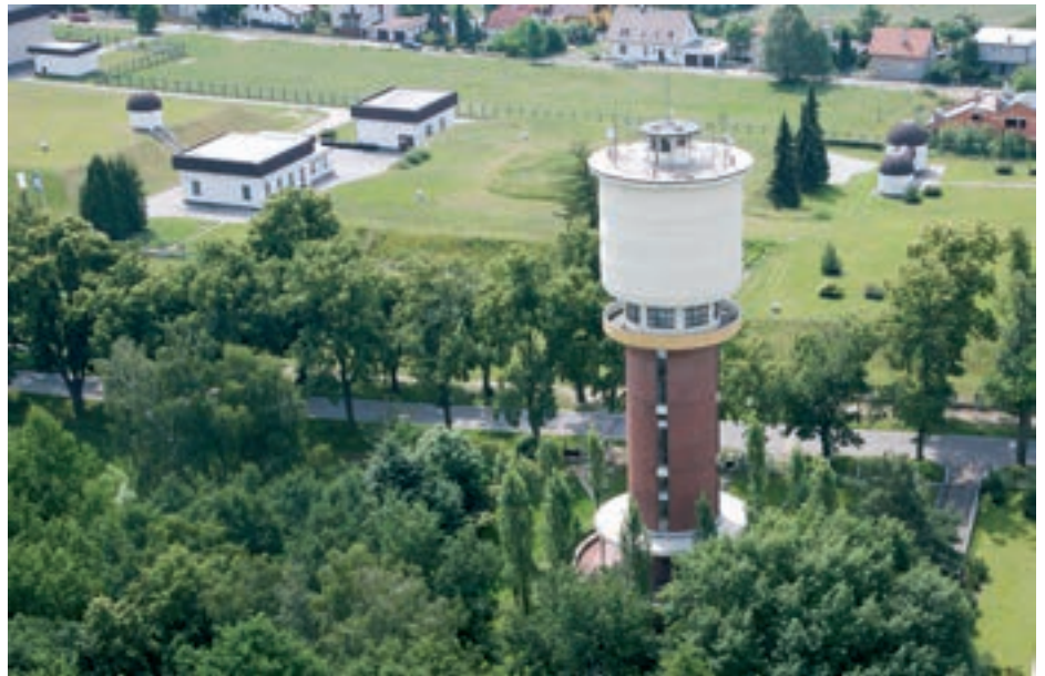
Vodárenská soustava východní Čechy – areál vodojemů Nový Hradec Králové
