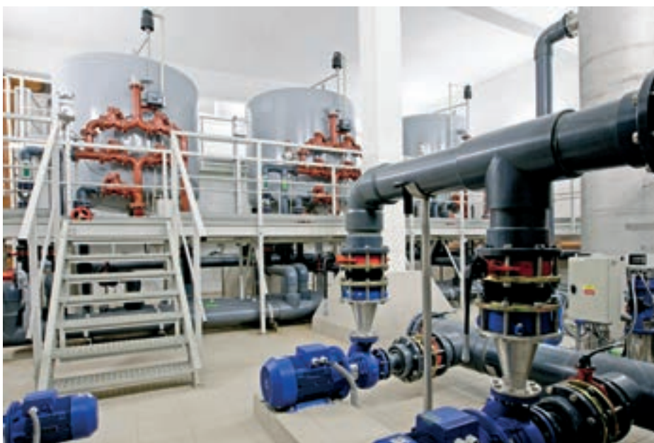
Vodárenská soustava východní Čechy – technologie úpravny vody Hájek
