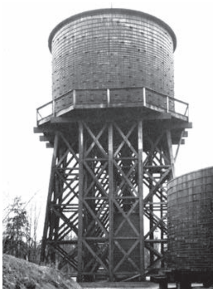
Obr. 11: Věžový vodojem z dřevěných dužin 125 000 gal (cca 473 m 3 ) (National Tank & Pipe Company, 1938)
