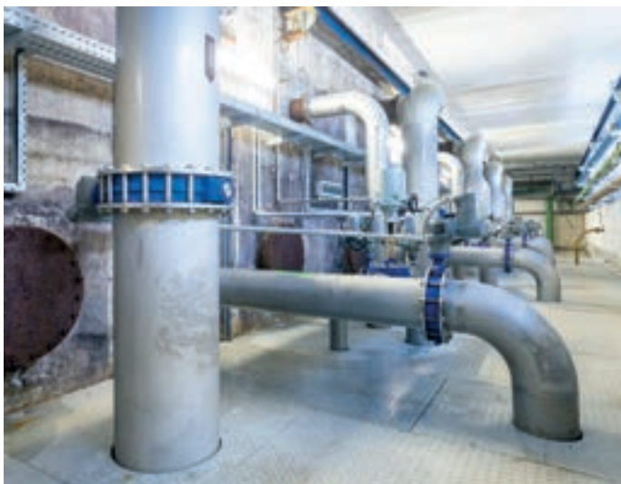
Potrubní rozvody pískových rychlofiltrů
