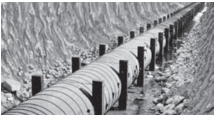
Obr. 8: Stabilizace průběžného dužinového potrubí při uložení do hlubokého výkopu. Stabilizace umožňovala použít standardní potrubí i v případech, kde by jinak bylo nutno ze statických důvodů použít potrubí ze zesílených dužin stažených větším počtem obručí (National Tank & Pipe Company, 1938)
