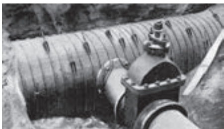
Obr. 5: Odbočení potrubí 12" (cca 0,31 m) z hlavního řádu 30" (cca 0,76 m) (Redwood Manufactures Co., 1911)
