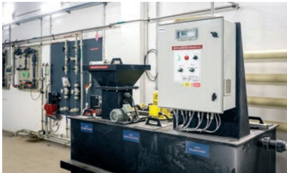
Automatická rozmíchávací stanice \text{KMnO}_4
