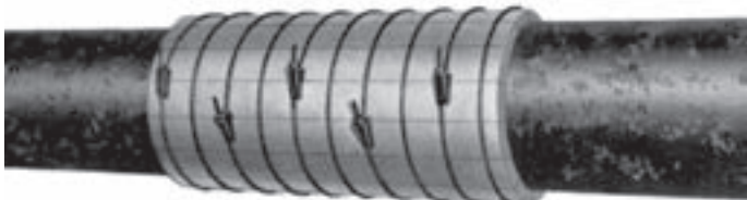
Obr. 10: Oprava ocelového potrubí pomocí dřevěných dužin (National Tank & Pipe Company, 1938)
