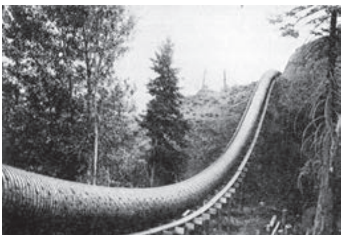
Obr. 9: Vertikální ohyb 48" (cca 1,22 m) dužinového průběžného potrubí, Walla Walla, Washington (Pacific Tank and Pipe Co., 1926)
