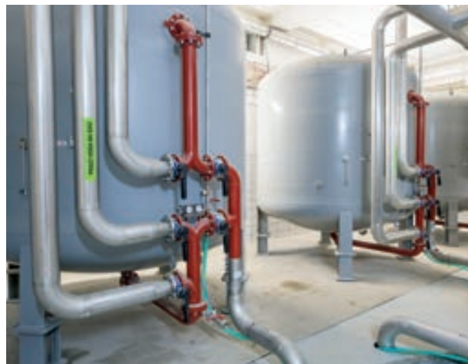
Tlakové GAU filtry
