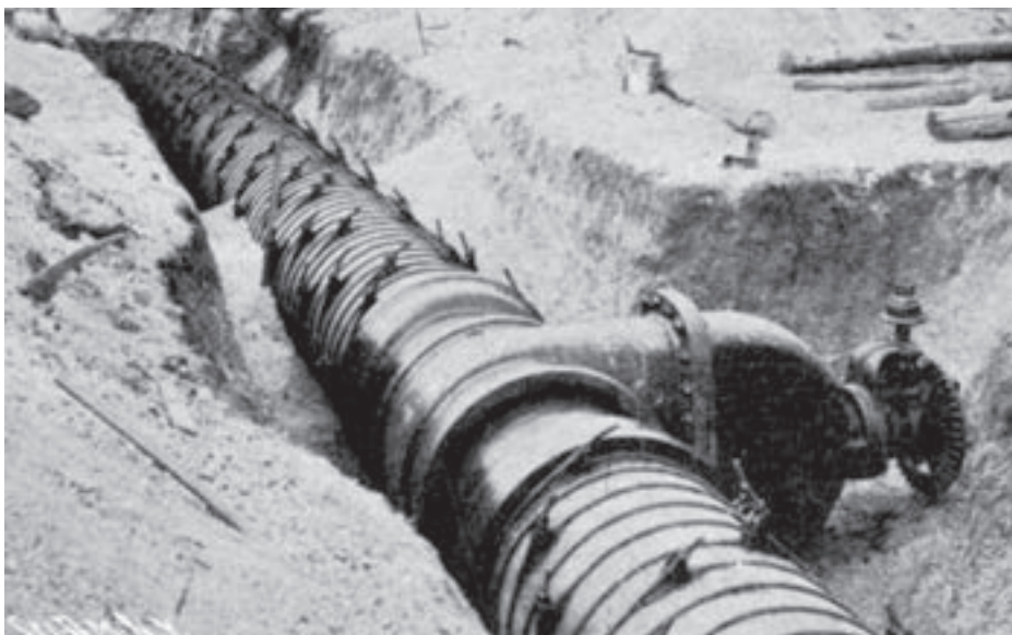
Obr. 4: Uzávěr na 24" (cca 0,61 m) potrubí (Scientific American, 1904)
