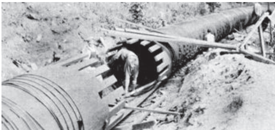
Obr. 7: Montáž průběžného dužinového potrubí 60" (cca 1,52 m), (National Tank & Pipe Company, 1938)
