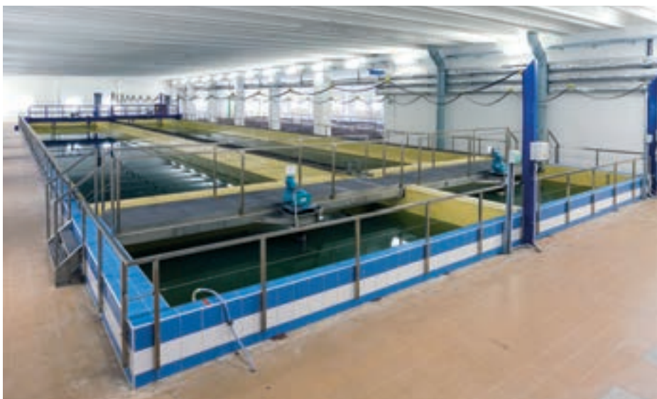
Hala usazovacích nádrží a filtrů
