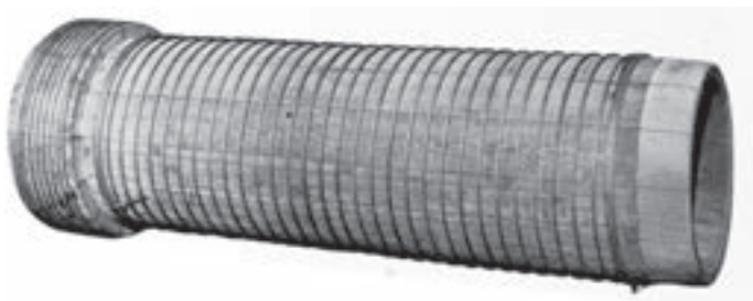
Obr. 1: Strojně vázané dužinové potrubí s hrdlem (National Tank & Pipe Company, 1938)
