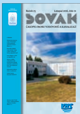
Titulní strana: Rekonstruovaná úpravní vody U Svaté Trojice v Kutné Hoře. Vlastník a provozovatel: Vodohospodářská společnost Vrchlice - Maleč, a. s.
