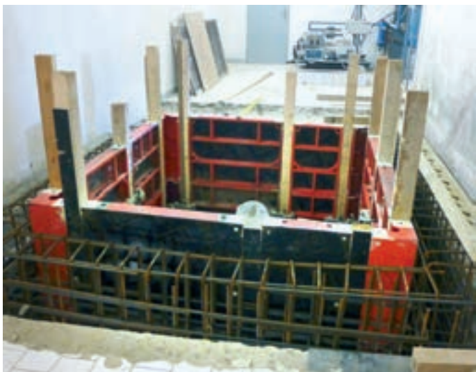
Nádrž rychlomísení připravená k betonáži
