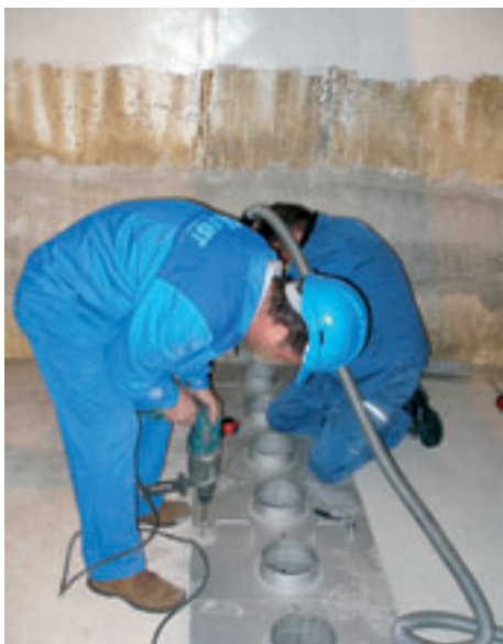
Obr. 5 a 6: Montáž drenážních segmentů v 1. filtrační komoře
