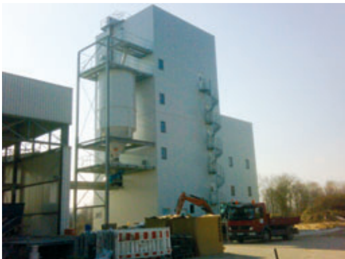
Obr. 5: Technologie zplyňování kalů na ČOV Mannheim (systém KOPF)
