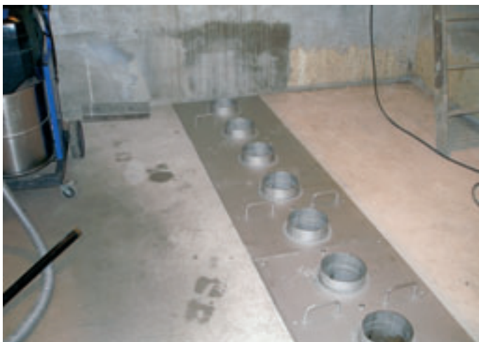
Obr. 3 a 4: Montáž drenážních segmentů v 1. filtrační komoře
