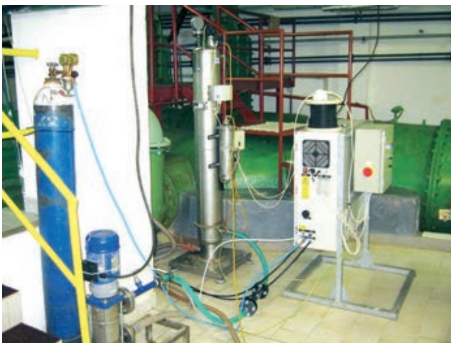
Ozonizátor GSO 10 při poloprovozních zkouškách
