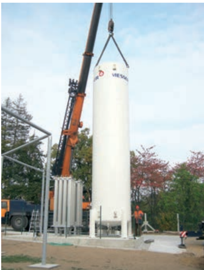
Instalace kryogenního zásobníku VT 31/18
