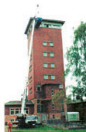
Obr. 10b: Věžový vodojem v době provádění sanačních prací, které při značné výšce vodojemu byly velmi drahé.
