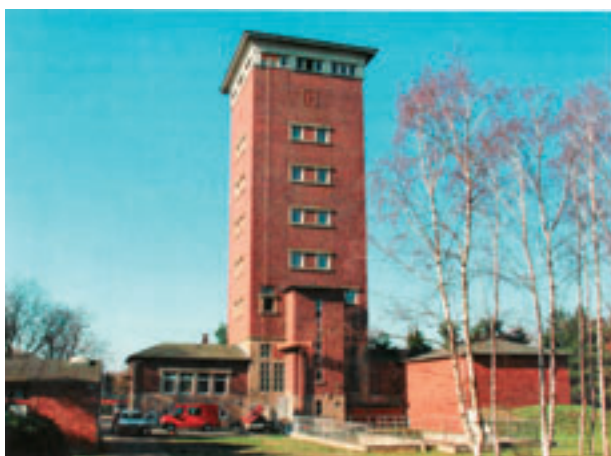
Obr. 10a: Historický věžový vodojem uprostřed města Emsdetten
