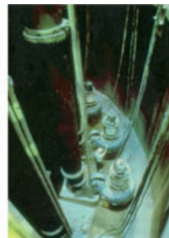
Betonová čerpací stanice pro velká ponorná čerpadla
