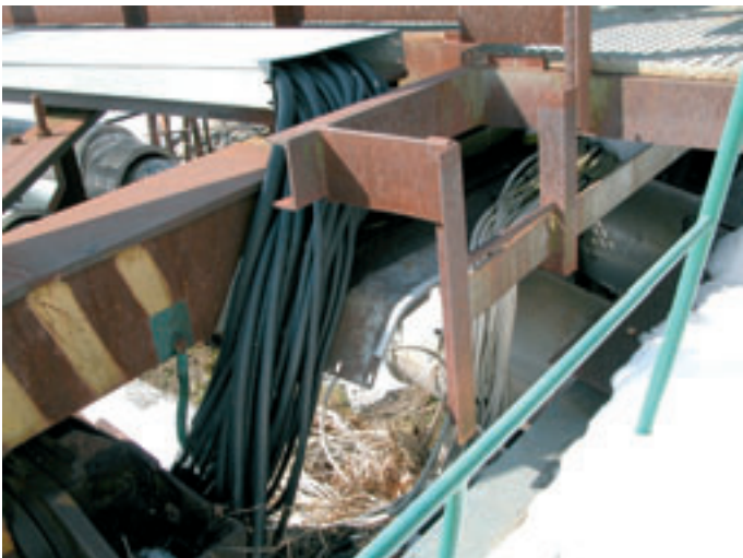
Úprava vedení ovládacích kabelů
