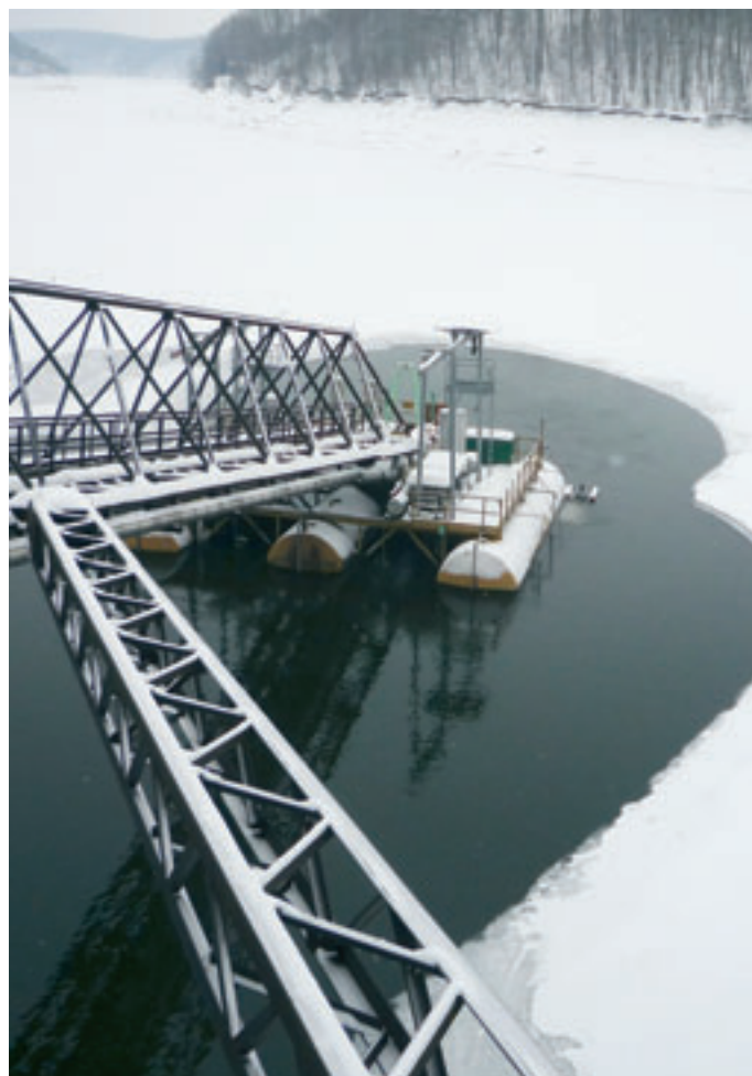
Plovoucí ponton, zamrzlá okolní hladina nádrže
