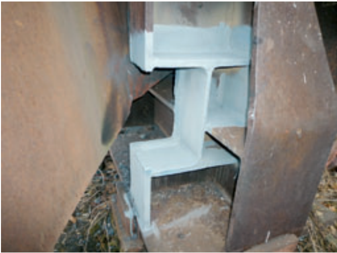
Dokončená úprava ukotvení ramene pontonu – vytvoření prostoru pro další pohyb ramene
