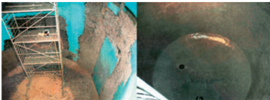
Obr. 11a a 11b: Nádrž ve vodojemu před a po sanaci
