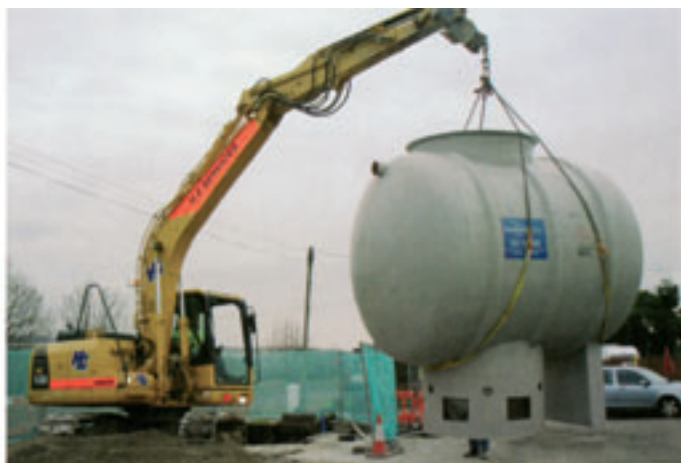
Osazování balené čerpací stanice na místo určení
