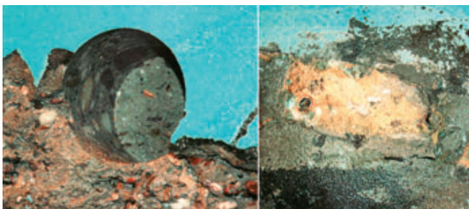
Obr. 9: Poškození betonového podkladu v nádrži věžového vodojemu v Emsdetten
