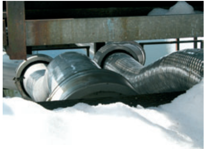
Úprava pohyblivých spojů na výtlačném potrubí
