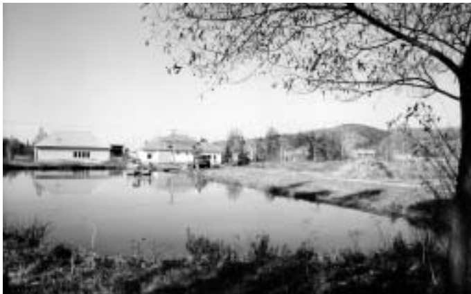
Obr. 1: Úpravna vody před rekonstrukcí
