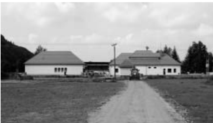
Obr. 2: Úpravna vody po rekonstrukci
