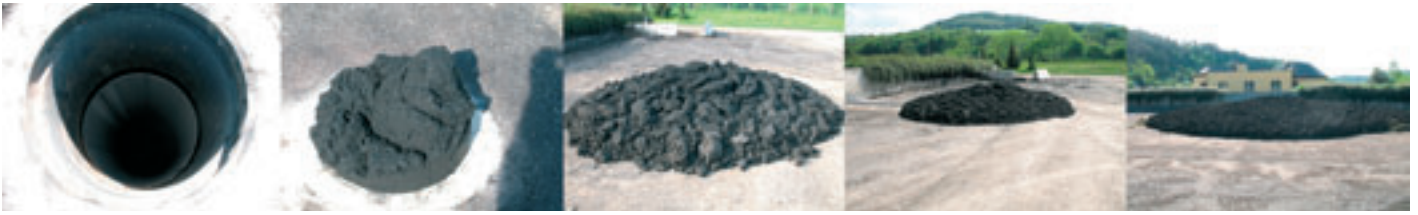
Obr. 4: Vyústění výtlačného potrubí vylišaného kalu na deponii
