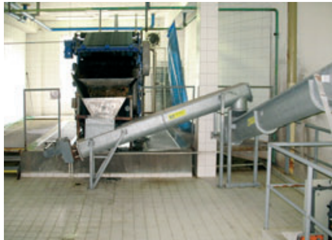
Obr. 1: Původní pásový lis se šnekovými dopravníky vylisovaného kalu
