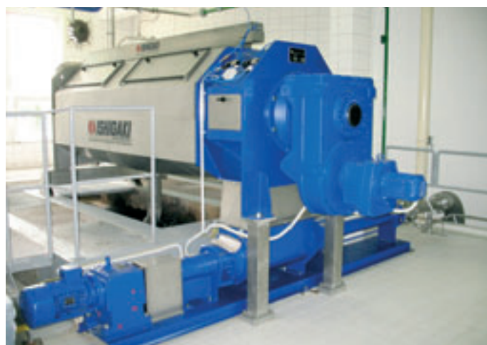
Obr. 2: Šnekový lis po instalaci vč. dopravního čerpadla vylisovaného kalu
