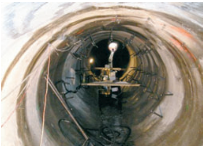
Kotvení ŽB ostění štolového přivaděče injekčními zavrtávacími kotvami
