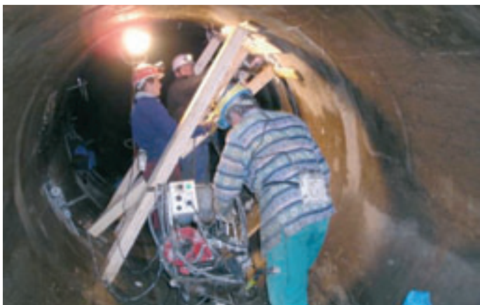
Sanace kaverny chemickou injektáží s příložným bedněním
