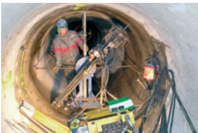
Vrtání injekčních a kotevních vrtů ve stísněných prostorách štolového přivaděče DN 2100
