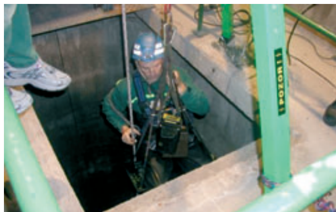
Komplikovaný přístup na pracoviště – svislá doprava osob
