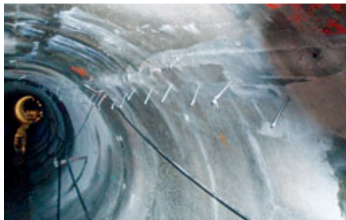
Sanace podélné trhliny ŽB ostění štolového přivaděče chemickou injektáží
