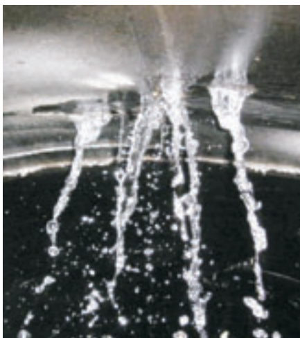
Příklad silných přítoků vody v ostění štolového přivaděče
