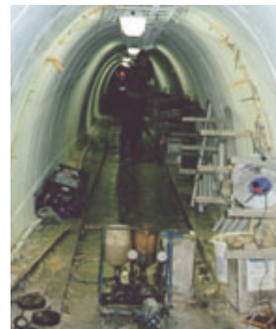
Provádění těsnicí injektáže příčných spár ŽB ostění stoly
