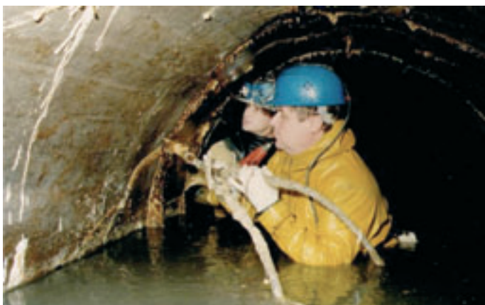
Sanace příčných trhlin a kaverny v kanalizačních sběračích za plného provozu
