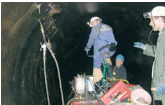
Injekční čerpadlo poháněné lidskou silou
