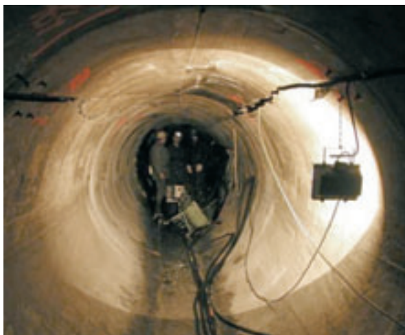
Podélná trhlina v železobetonovém ostění štolového přivaděče
