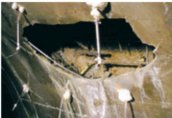
Sanace kaveren v ŽB ostění štolového přivaděče
