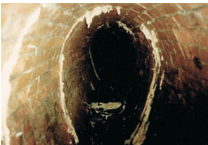
Sanace příčných trhlin v cihelném ostění kanalizačního sběrače
