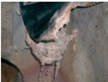
Obr. 6: Nevýhody z hlediska provozovatele kanalizace: jakákoliv netěsnost se projeví výraznou inkrustací
