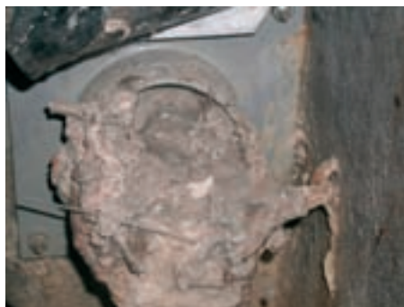
Obr. 6: Nevýhody z hlediska provozovatele kanalizace: jakákoliv netěsnost se projeví výraznou inkrustací
