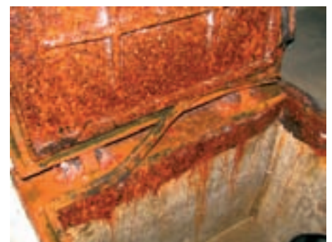
Obr. 5: Nevýhody z hlediska provozovatele kanalizace: stoky jsou omezené a velmi problematicky větratelné
