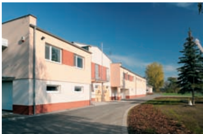
Obr. 3: Úprava vody v Lednici – provozní budova
