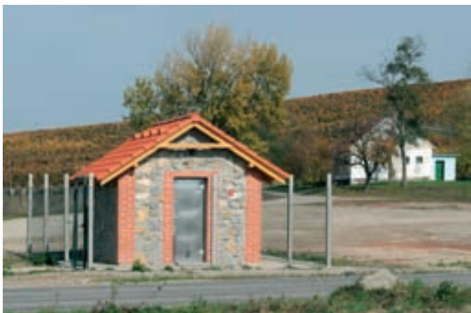
Obr. 10: Čerpací stanice Novosedly
