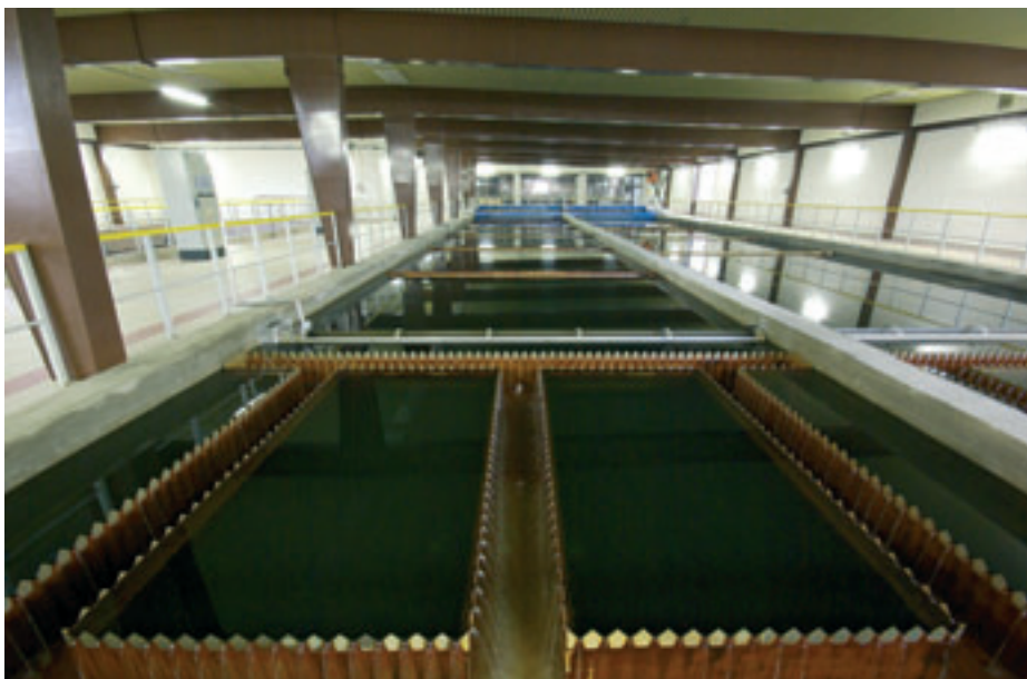
Úpravna vody Štítary po rekonstrukci
